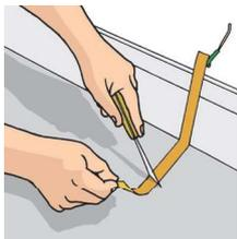
**26.1.** El aterramiento debe ser hecho antes de la disposición de los rollos. Para fijar la cinta de cobre, aplique el adhesivo conductivo con pincel en el contrapiso y sobre la cinta de cobre;
